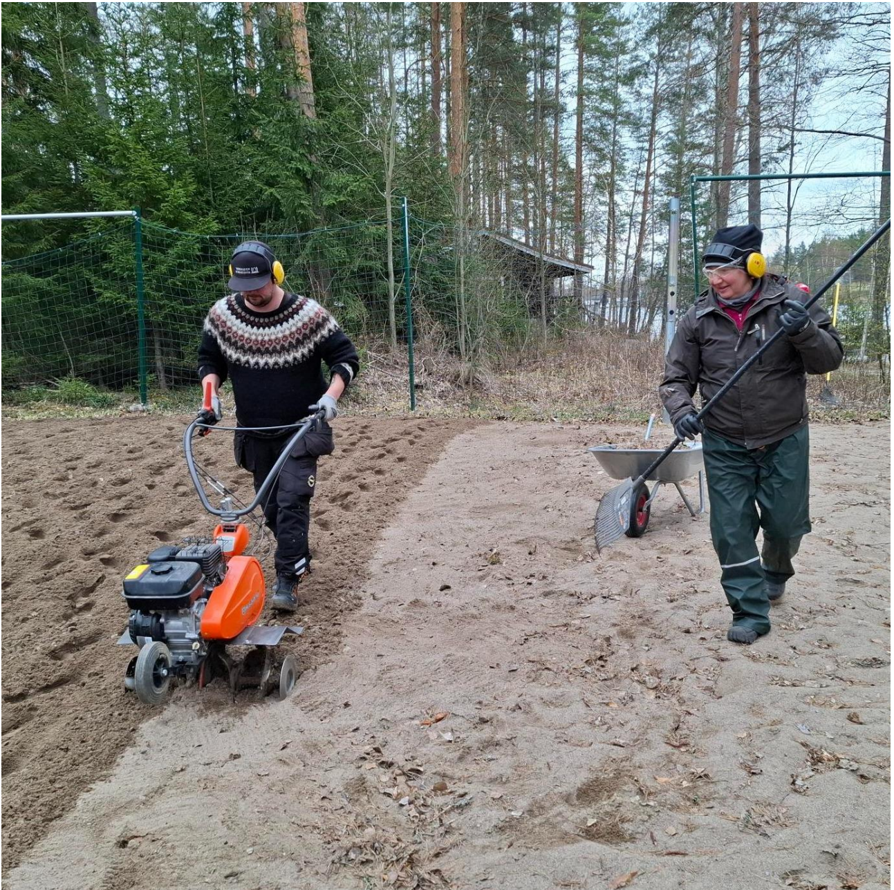
KUVA 9 TOUKOKUUSSA TALKOILTIIN PUURTILAN SEURAKUNTAKOTI KESÄKUNTOON. KUVA TIINA TAAVITSAINEN.
